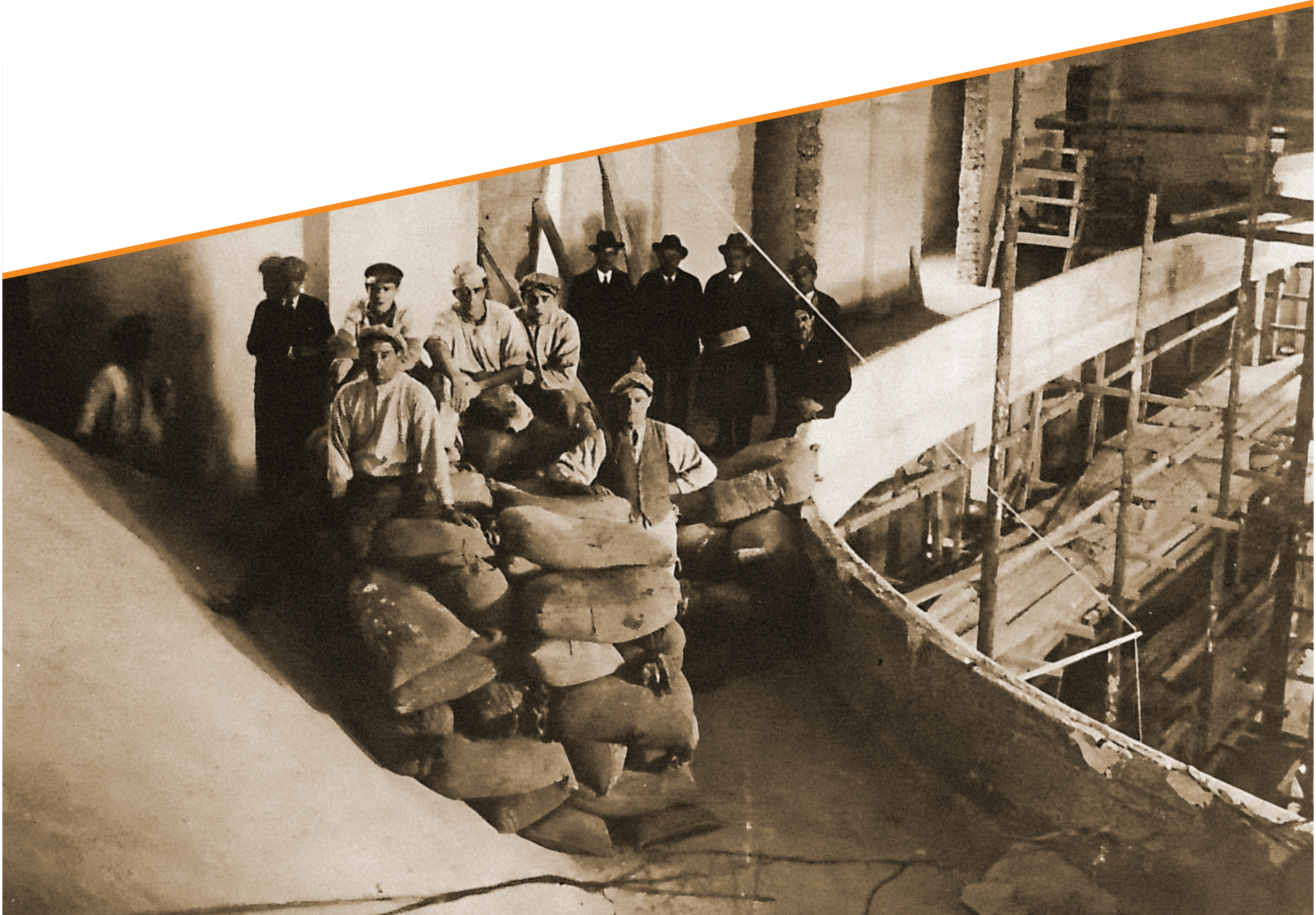
Foto di repertorio: Andrea Cantero nel cantiere di realizzazione del nuovo Teatro (1926-1931)
